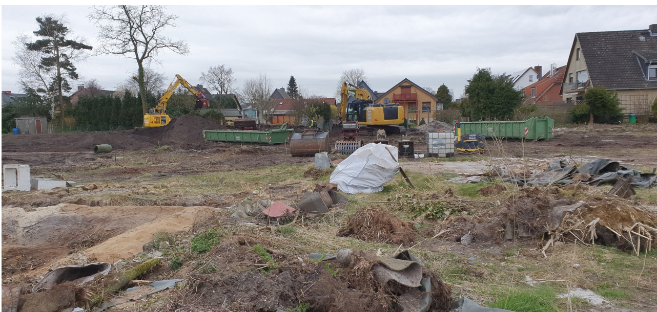
Foto 1: Rückbauarbeiten mit Siebung des Mutterbodens, Foto 18.03.2020, Amt Geest und Marsch Südholstein
